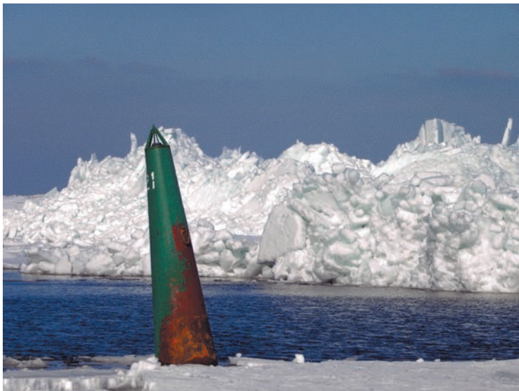
Рис. 9. Морская часть ВКМСК зимой. Дрейфующий под действием ветра и течений лед, как бульдозером, сдвигает с бровок намытый грунт вновь в ложе канала.
