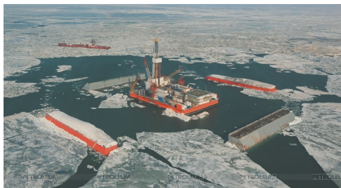
Рис. 7. Специально сконструированные и построенные на астраханских верфях баржи «Ледовый барьер» надёжно защищают буровой объект от воздействия дрейфующих льдов.
