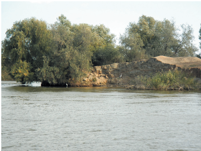
Рис. 7. В результате, изъятый грунт вскоре вновь возвращается в ложе канала.
