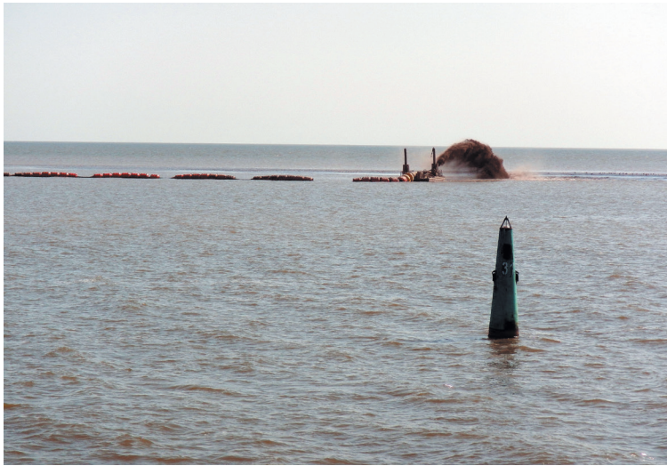
Рис. 8. Сизифов труд. Изъятый в морской части канала грунт вскоре вновь попадет в ложе канала под воздействием течений, волнения и дрейфующих льдов канала.
